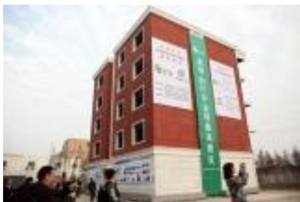
Рисунок 2. Многоквартирный жилой дом, напечатанный по технологии строительной 3D-печати
