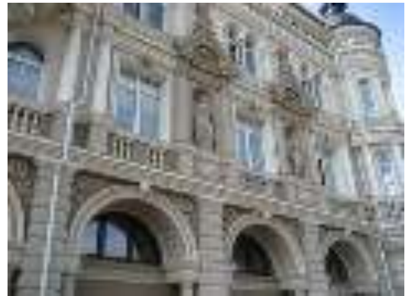
Рисунок 2. Декорирование фасада стеклофибробетоном.
