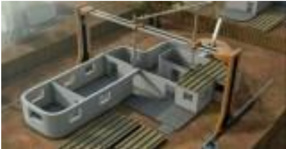
Рисунок 4. Пример порталной установки, сооружаемой на строительном объекте
