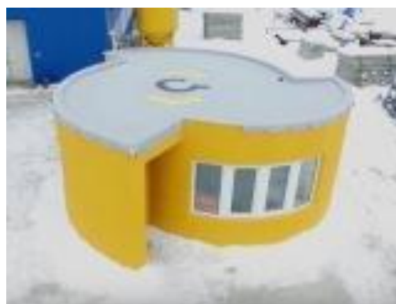
Рис. 3. Жилое здание, напечатанное мобильным строительным 3D-принтером, расположенным в центре возводимого объекта
