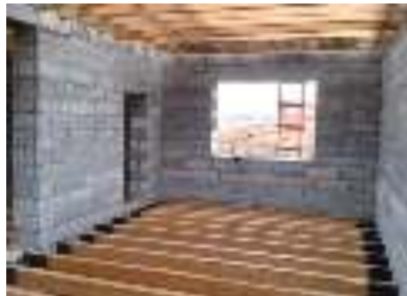
Рис. 3. Возведение стен из полистиролбетонных блоков
