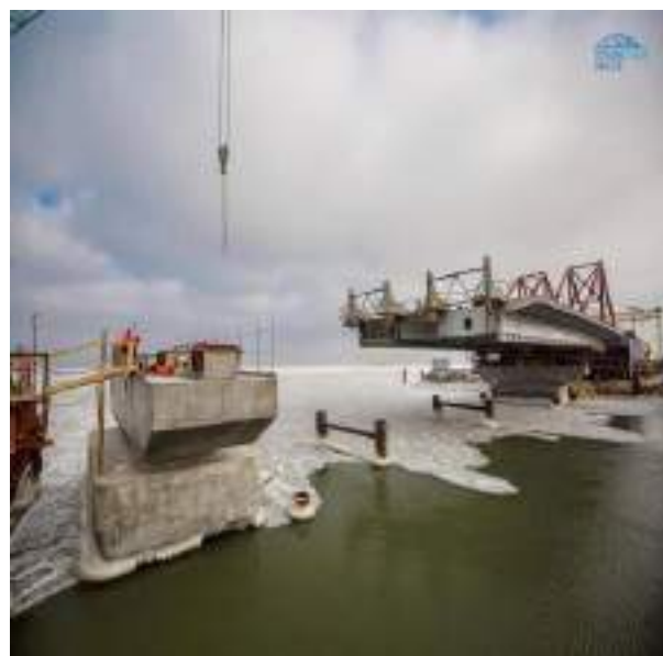
Рисунок 2. Монтаж пролетов между опорами. http://www.most.life/multimedia/foto/
