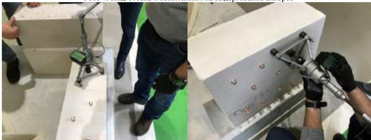
Фото 5. Проведение испытаний на выдергивание анкера из блока при расположении прибора в вертикальном и горизонтальном положениях
