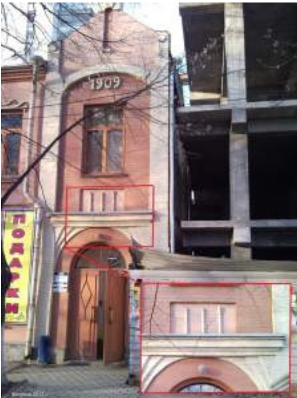
Рисунок 10. Фотография объекта и начало деформаций перемычек в процессе строительства нового каркасного здания в 2011 г.
