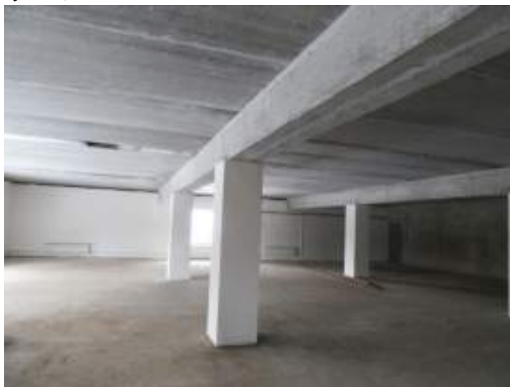
Рисунок 1. Общий вид перекрытия, колонн и ж.б. балок обследуемого помещения
