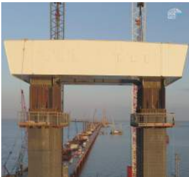
Рисунок 1. Возведение фарватерных опор. http://www.most.life/multimedia/foto/
