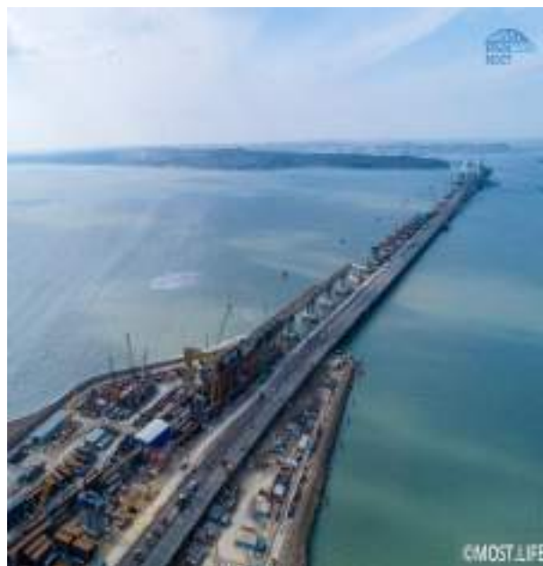
Рисунок 3. Строительство Крымского моста в Керченском проливе. http://www.most.life/multimedia/foto/
