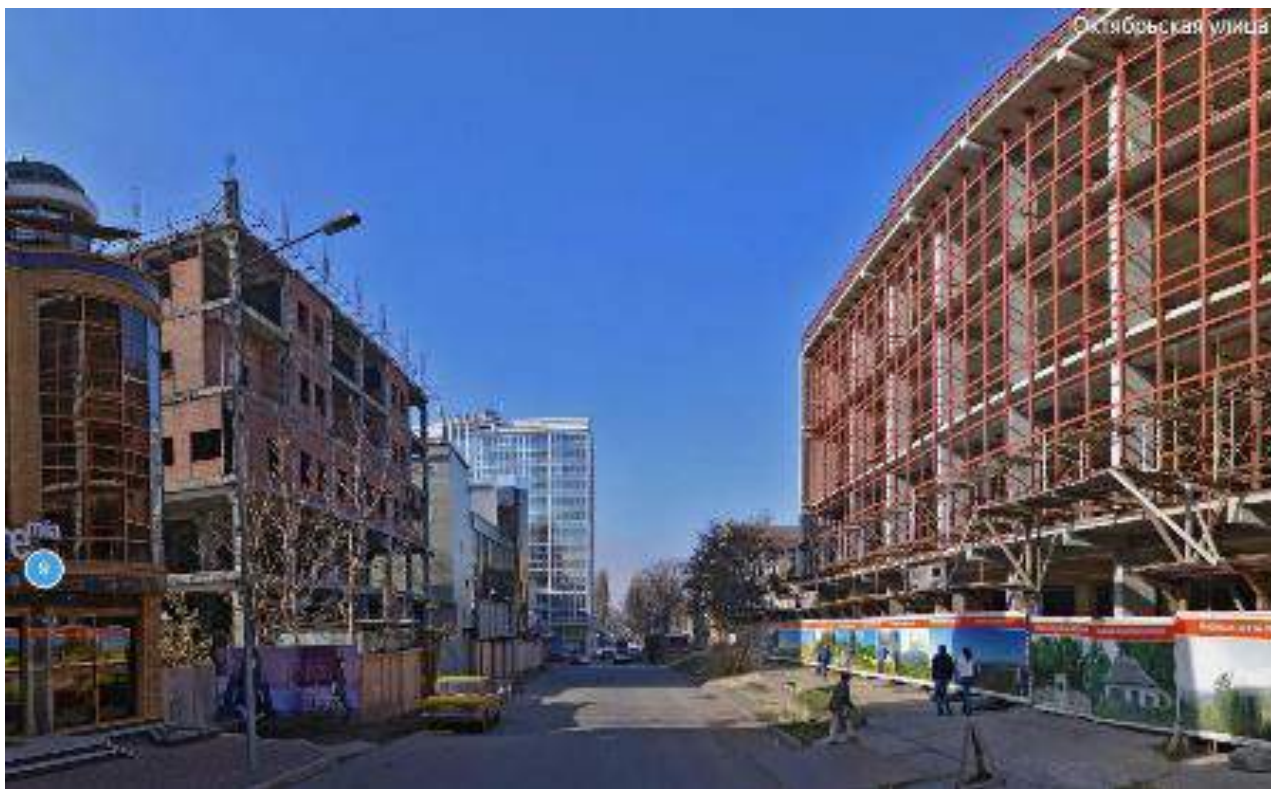
Рисунок 7. Центр г. Пятигорска. Два новых здания не вводятся в эксплуатацию более десяти лет левое здание и пяти лет правое
